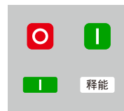
断路器合闸且无储能状态
